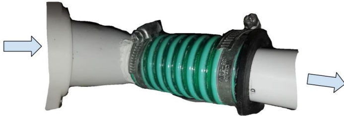
Anschluss-Stutzen an Toilette , Ausführung des Übergangs gemäß Foto
